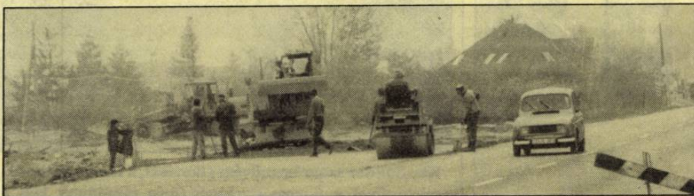
Épül a 70/A út nyugati bevezető szakasza
