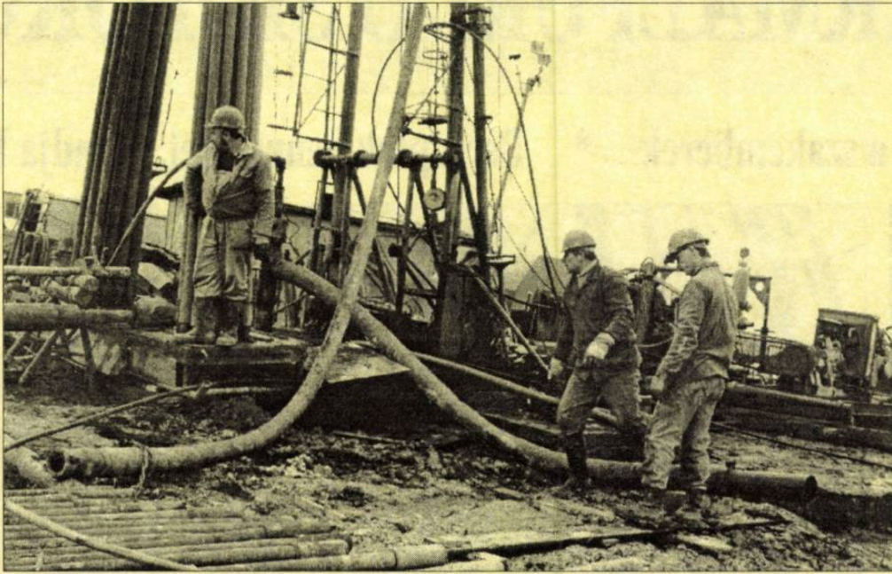
A cső a kútfejen, indulhat a nyomáspróba!
