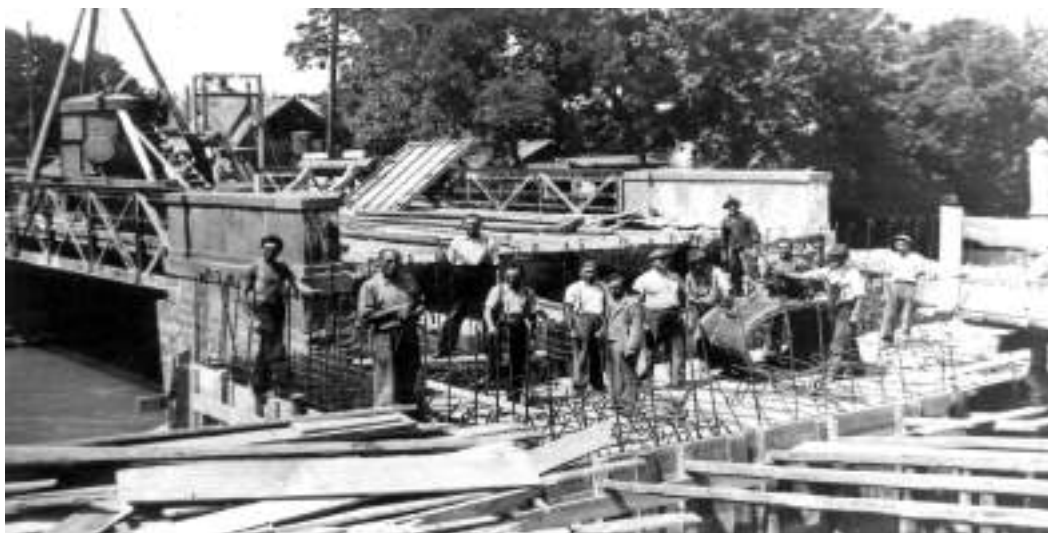
A felrobbantott közúti híd újjáépítése
