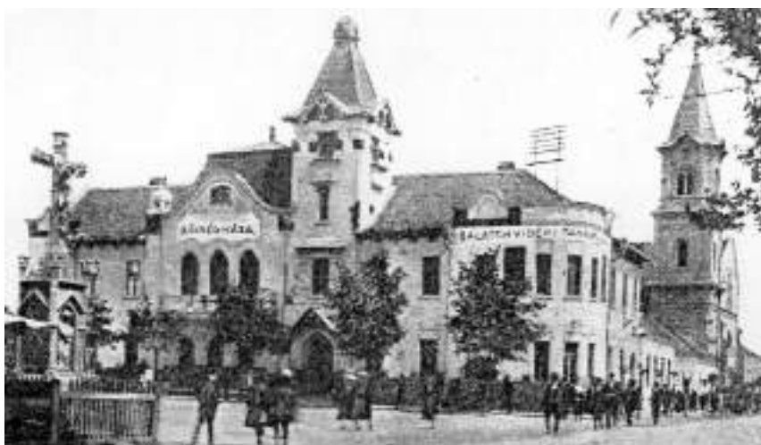
Az 1908-ban épült Községháza
