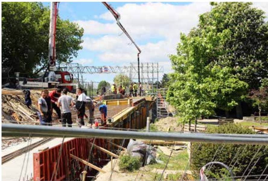
Május végi pillanatfelvétel: sokan és serényen dolgoztak a hídon, de sok munka volt még hátra...
