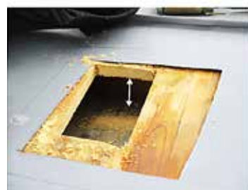
A deszkázat alatti mintegy 8 cm vastagságú légréteg található.
