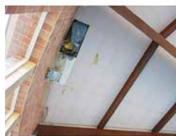
Van, ahol a vízzel telített álmennyezeti elem le is esett.
