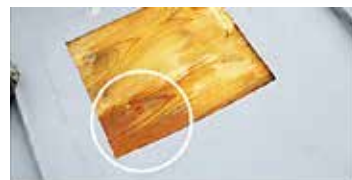
A horngyálmennyező alól a deszkázat felületén folyt a víz.
