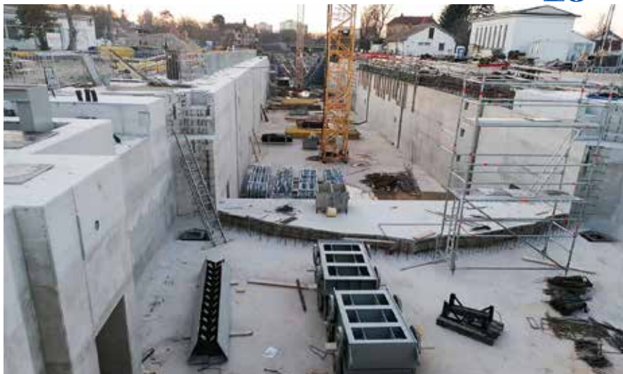
Az épülő hajózási szilip. Ősszel indulhat az új vízleeresztő szilip építése.
